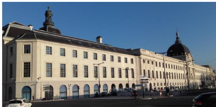
Figure 16 – L'Hôtel-Dieu à Lyon. Combinaison de pierre de Villebois, d'un ton foncé, pour le soubassement et le rez-de-chaussée, et la pierre de Seyssel, bien plus claire, pour les étages (source : Rhônapi)
